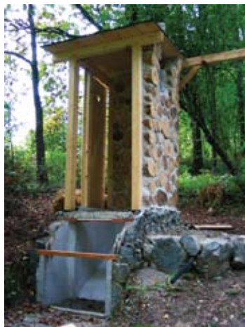
POČETAK GRADNJE VANJSKOG KOMPOSTNOG WC-A (RECIKLIRANO IMANJE, VUKOMERIĆ)
