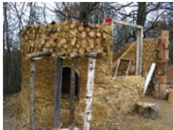
Lijevo: Pokusna žbuka sa slamom, vodom, piljevinom i vapnom; desno: pokusna gradnja sa drvenim kladama. Ekoselo u nastajanju u Blatuši
