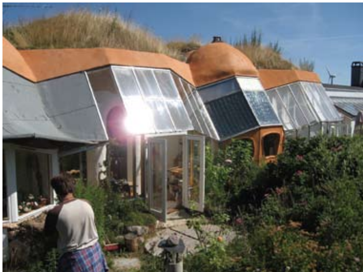
Pasivna solarna gradnja sa zelenim krovom, ekoselo Dyssekilde, Danska. Foto: Alex Cicelsky, Kibbutz Lotan
