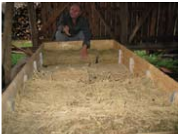
Lijevo: Pokusna žbuka sa slamom, vodom, piljevinom i vapnom; desno: pokusna gradnja sa drvenim kladama. Ekoselo u nastajanju u Blatuši
